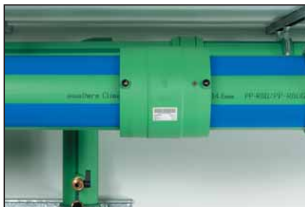
Utaknuti u spojnicu drugi, isto tako oljušteni, čisti kraj cijevi
