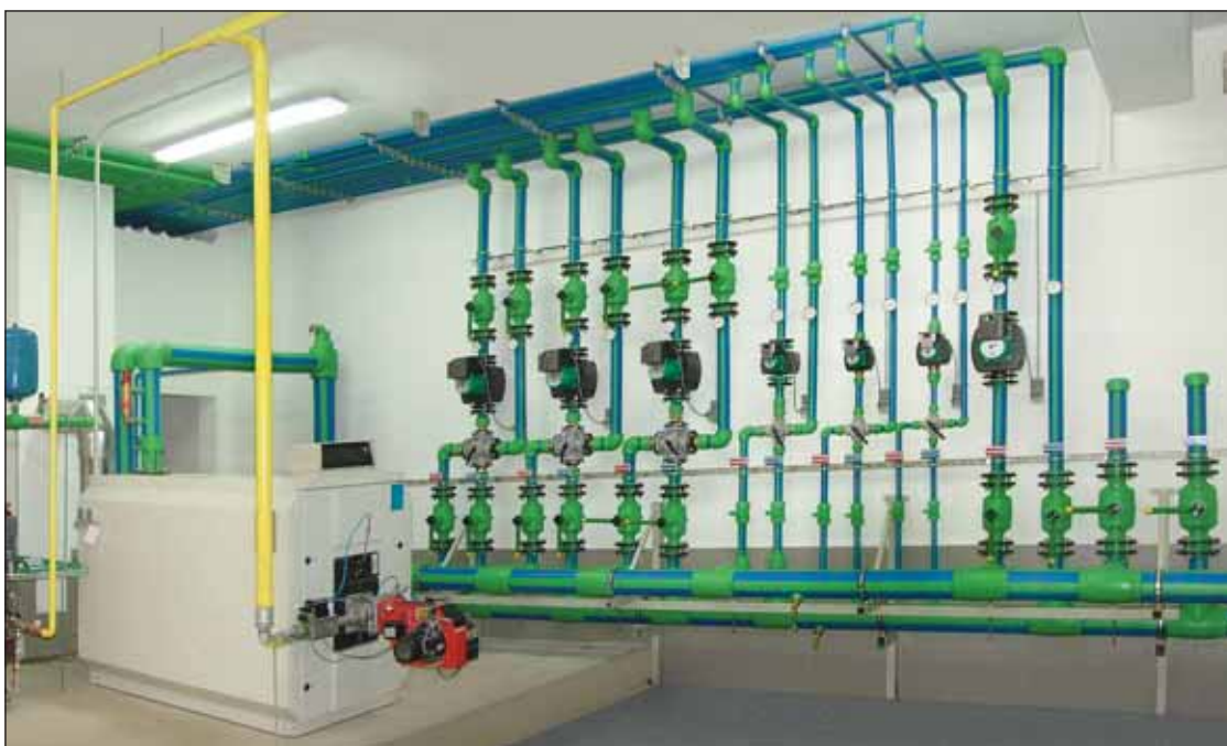
Razdjelnik grijanja climatherm -cjevovodni sustav
