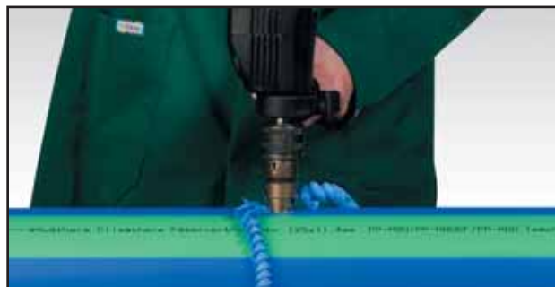
Bušenje stijenke cijevi
