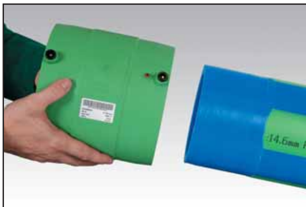
Nataknuti E-spojnicu na kraj cijevi
