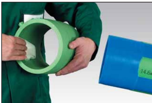
Očistiti unutarnju površinu E-spojnice
